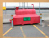
Dispositif de récupération des huiles usées dans un port canadien. (Source : Galien Myre)
